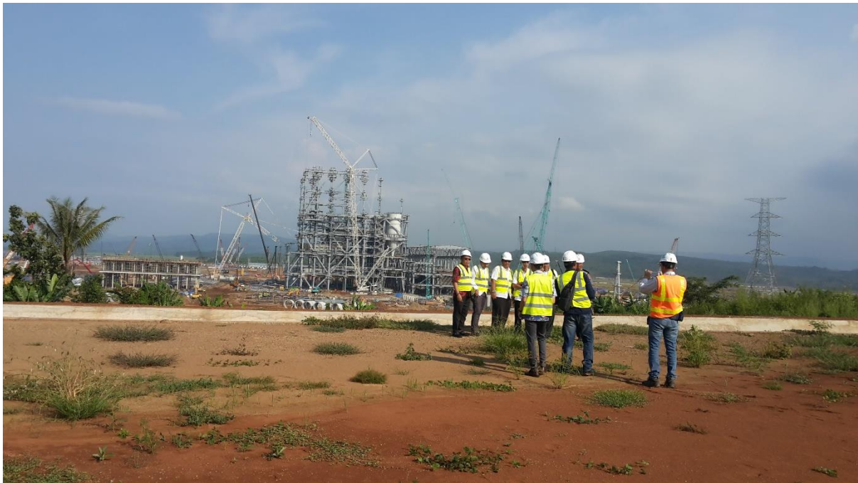
Lokasi Pembangunan Proyek PLTU Batang
